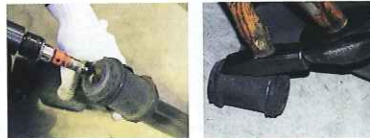
まずはホールソーでカラーの傘の部分を開く。ハンマーの後ろなどを使って抜き取る。
