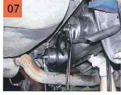
07 カップ部分のボルトをレンチで回しながら、マウントの位置を微調整して行く。
