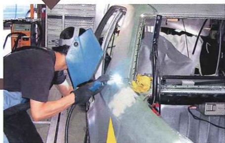
高張力鋼板のパネル交換時にメーカーが指定するパルスミグ溶接機は800℃と、従来の半分以下で作業可能で、熱変性問題も少ない。
