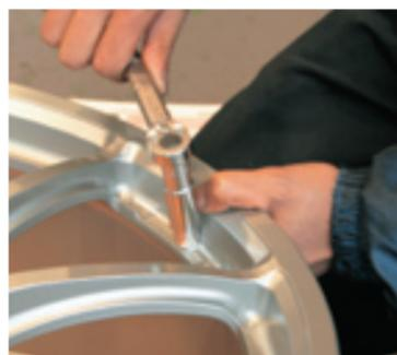
コックピット21世田谷店では、バルブからの空気漏れ防止のために、ホイールへのバルブ装着もトルクレンチを使用する。
